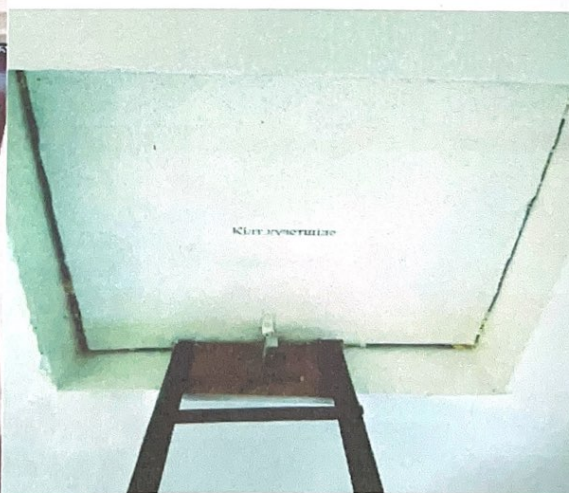
Выход на чердак
